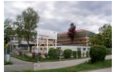
Energetische Sanierung der Realschule Marktoberdorf
