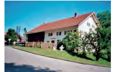
Das ausgebautе Dachgeschoss des Baschtlehauses Ebenhofen beherbergt nun das neue Hirtenmuseum
