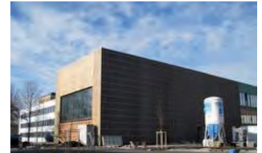
Blick auf die Holzverkleidung am Sitzungssaal
