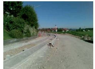
Ausbau der Kreisstraße OAL 23
