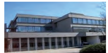
Neue Holzfassade der Realschule Buchloe
