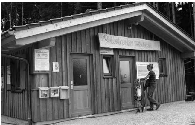
In dem vor wenigen Monaten errichteten Funktionsgebäude sind nun die Kasse, der Umkleidebereich, das Ausstattungslager und sanitäre Einrichtungen unter einem Dach.
