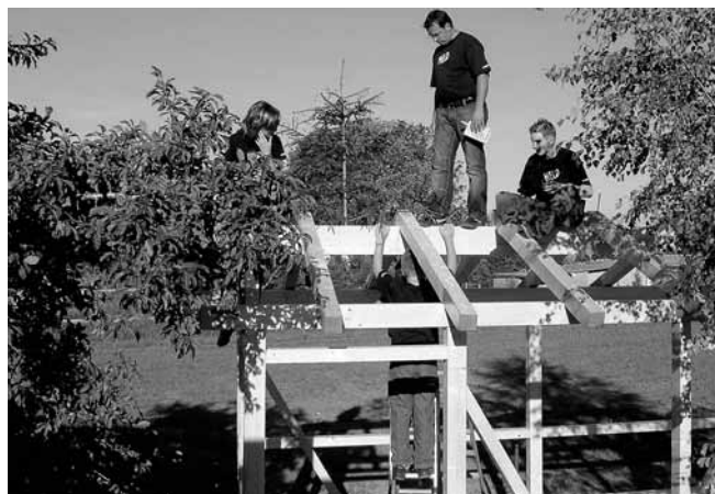
Schwindelfrei und sattelfest in Statikfragen erwies sich die Jugendfeuerwehr Ketterschwang bei der Neugestaltung des Kindergartens St. Peter und Paul in Dillishausen.
