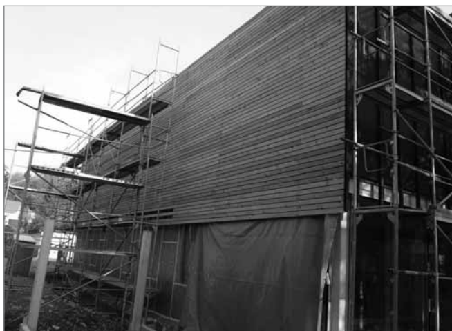
Die Bauarbeiten der „Schatzkiste Obergünzburg“ sind in vollem Gang.
