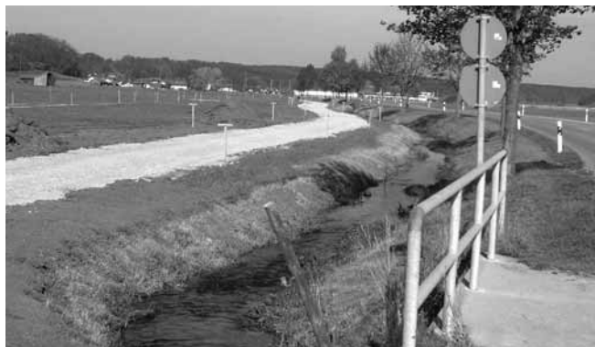
Arbeiten am Radweg Romatsried – Eggenthal, OAL 3, im Oktober 2007
