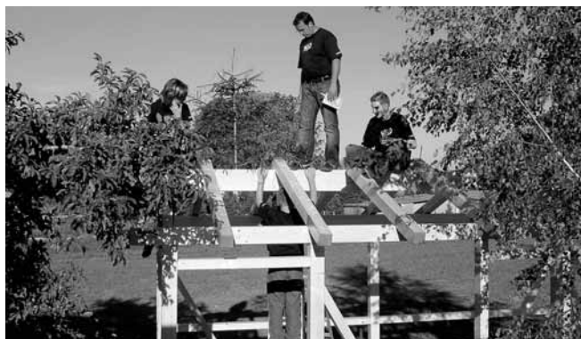
Schwindelfrei und sattelfest in Statikfragen erwies sich die Jugendfeuerwehr Ketterschwang bei der Neugestaltung des Kindergartens St. Peter und Paul in Dillishausen.
