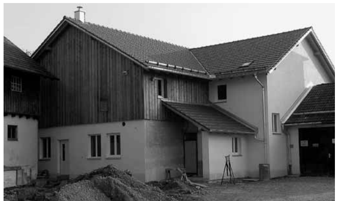
Das Dorfhaus wird nach der Fertigstellung der Mittelpunkt des dörflichen Lebens in Emmenhausen / Markt Waal sein.
