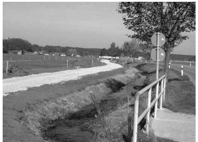
Arbeiten am Radweg Romatsried–Eggenthal, OAL 3, im Oktober 2007
